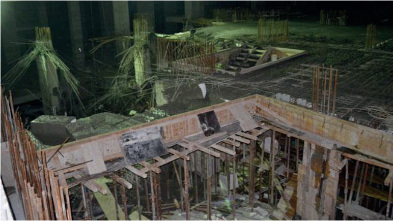
Şekil 1: Girne’de bir inşaatta 6 kişinin yaralanmasına yol açan kalıbın çökmesi.
