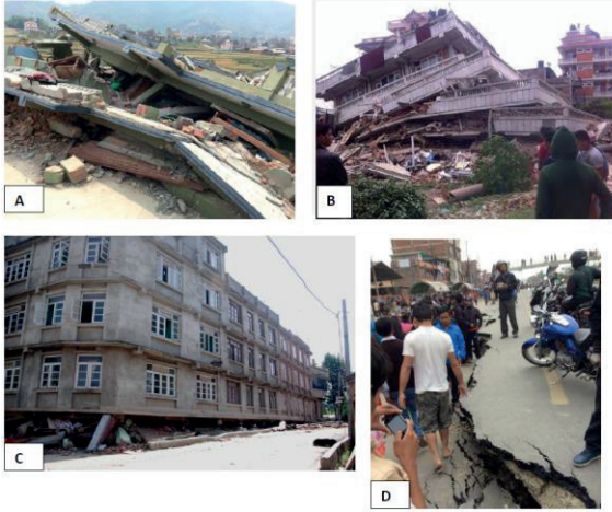
Şekil 10: Gorkha depremi sırasında Katmandu'daki yapı hatalarının modelleri (A, B ve C). Yeni modern binaların çoğu zayıf sütun ve giriş inşası nedeniyle çöktü. D: Zemindeki bozulmadan kaynaklı Katmandu-Bhaktapur otoyolundaki hasar.
